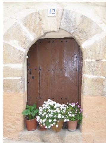
Fig. 8. Arco en Monroyo (12-2010)
